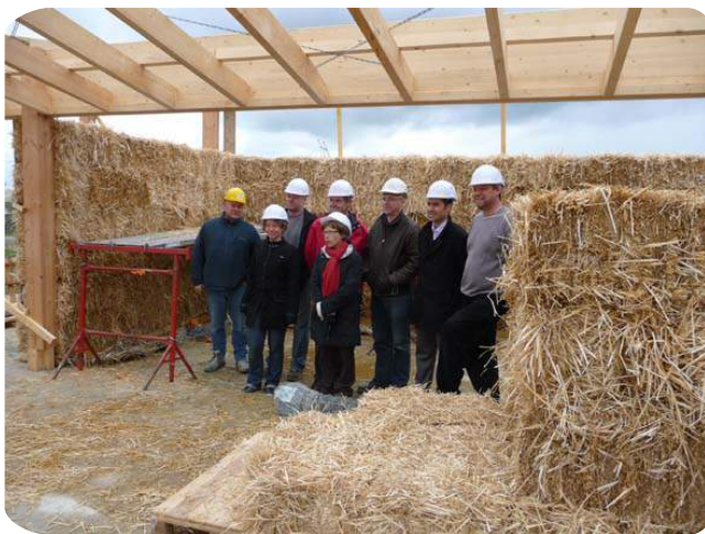
Évaluation sur chantier - paille porteuse en technique expérimentale dans un ERP - ville de Bourg en Bresse © V.Rigassi Architecte
