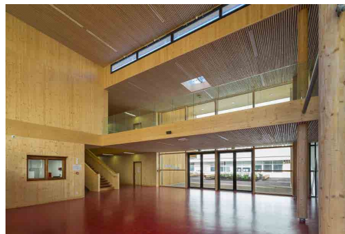
▲ Habillage des murs intérieurs en panneaux 3 plis
