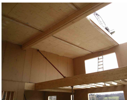
▲ Sous-face des caissons de toit en panneaux 3 plis
